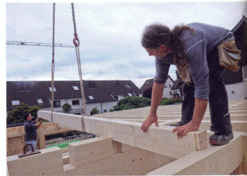
Der Richtmeister übernimmt Deckenbalken vom Kran © uwe weiser / FULLWOOD
