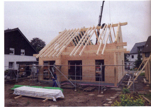
Baufortschritt: Gerüstbauer beginnen © uwe weiser / FULLWOOD
