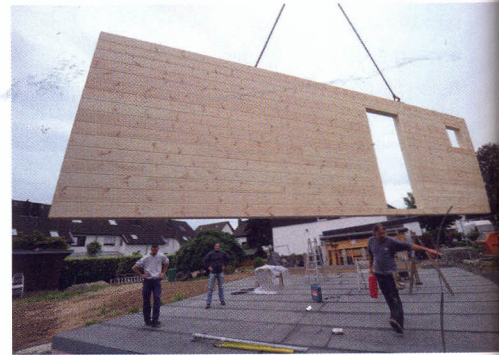
Die erste Wand schwebt herbei © uwe weiser / FULLWOOD
