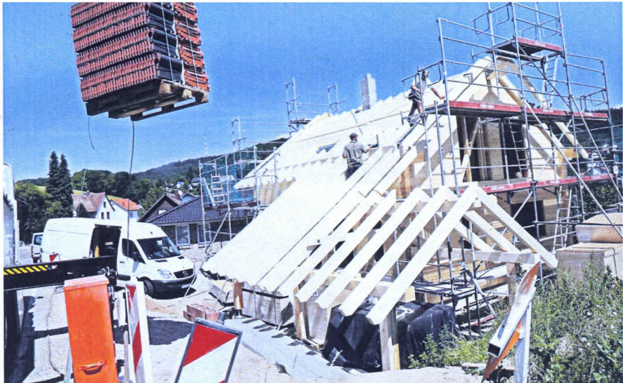
Es steckt noch viel Arbeit in Klaus Ries' Kindheitstraum von einem eigenen Massivholzhaus – doch wenn alles nach Plan verläuft, können er und seine Frau Marion bereits im September nach Unter-Abtsteinach ziehen.
