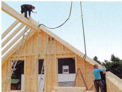
Eine Dachsparre wird vom Kran gehievt.
