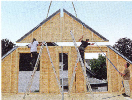
Letztes Teil der Giebelwand kommt per Kran.
