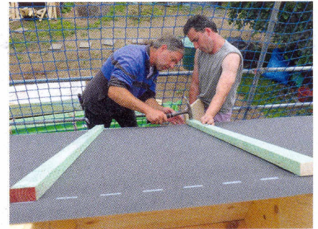
Anleitung zum Befestigen der Dachfolie.
